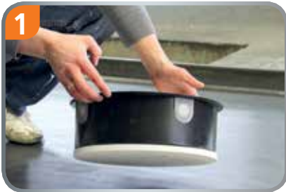
1 Bei Ortbeton auf Schalung nageln, im Fertigteilwerk auf Schaltisch kleben.
