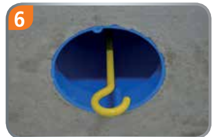
Montage mit Deckenhaken. (Maximale Belastung 10 kg).
