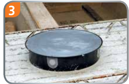
3 Betonfertigteil wird gegossen.
