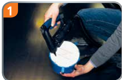
1 XL 170 Großdose mit Heißkleber auf den Schaltisch kleben.
