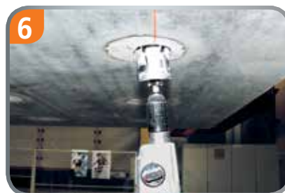
6 Mit einem Lochschneider wird die individuelle Öffnung ausgebohrt und an die Mineralfaserplatte angespachtelt.
