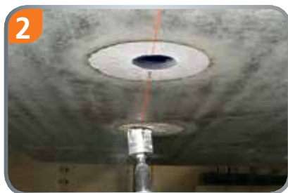
Individuelle Öffnungen können ausgebohrt werden.
