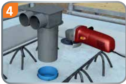
Stutzen auf gewünschte Länge kürzen und in Hülse einschieben.
