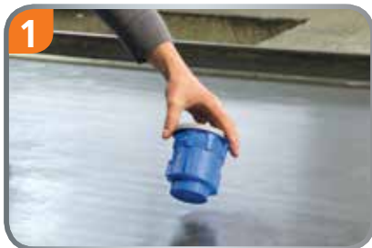
1. Variante: Mit Heißkleber auf Schaltisch kleben.
