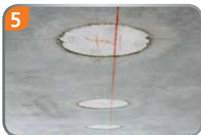
5 Fluchtlinie anzeichnen, Ungenauigkeiten können jetzt korrigiert werden.
