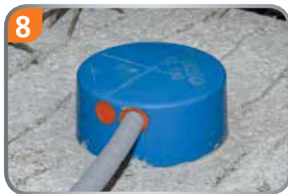
M20- oder M25-Rohr einschieben.
