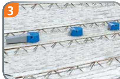
3 Betonfertigteil wird gegossen.
