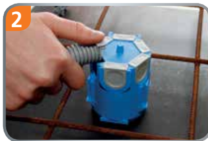
2 Rohr mit Quick-Fix-Schieber einschieben und schließen.
