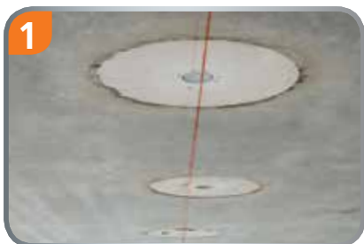
Linie anzeichnen, Ungenauigkeiten durch Ø 190 mm leicht korrigierbar.
