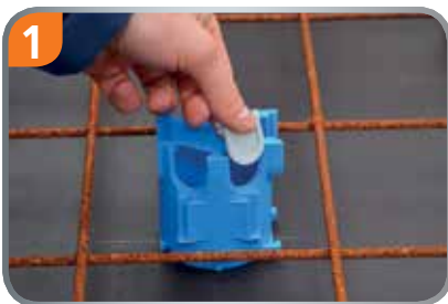
1 Dosenkörper auf Schalung aufkleben. Nicht benötigte Öffnungen schließen.
