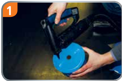
1. Variante: Mit Heißkleber auf Schaltisch kleben.
