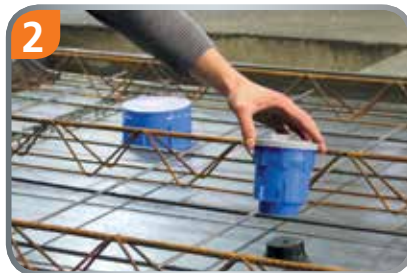
2. Variante: Mit Magnet auf Schaltisch positionieren.
