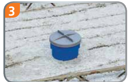
Betonfertigteil wird gegossen.
