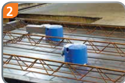
2 XL 170 Großdose wahlweise mit oder ohne Trafotunnel montieren.
