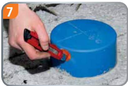
TPE-Öffnung mit Cuttermesser einschneiden.
