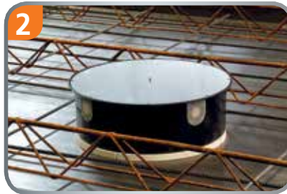
2 Stabile Blechplatte – kein Stützrohr nötig.
