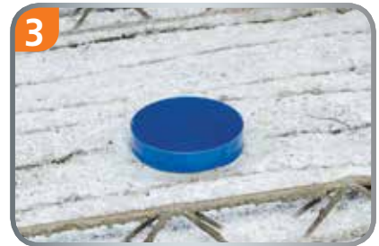
Betonfertigteil wird gegossen.
