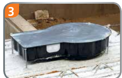
3 Betonfertigteil wird gegossen.
