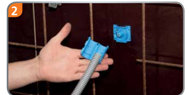
2 Rohr M20 oder M25 einklicken. Absolut sichere Zugentlastung.
