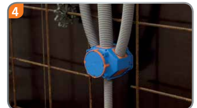
Rohre einführen. Für bis zu 6 Installationsrohre M20/25 geeignet, oder 4x M20/25 plus 2x M32 - auch starre Rohre.
