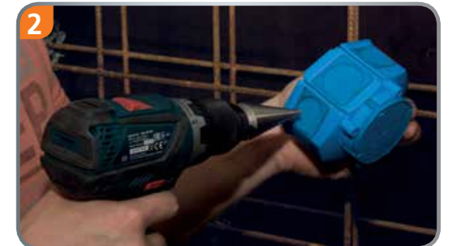
Rohrlöcher ausbohren...
