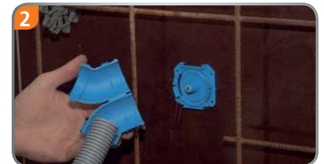
2 Rohr M32 oder M40 einklicken. Absolut sichere Zugentlastung.
