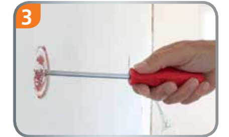
3 Zum Schluß mit einem Schraubenzieher den Putzdeckel entfernen.
