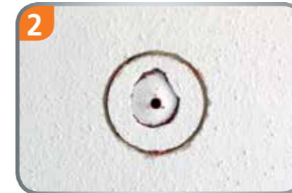
2 Eine saubere Kontur ohne Abbrüche entsteht.
