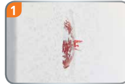
1 Nach dem Verputzen steht der Putzdeckel hervor.
