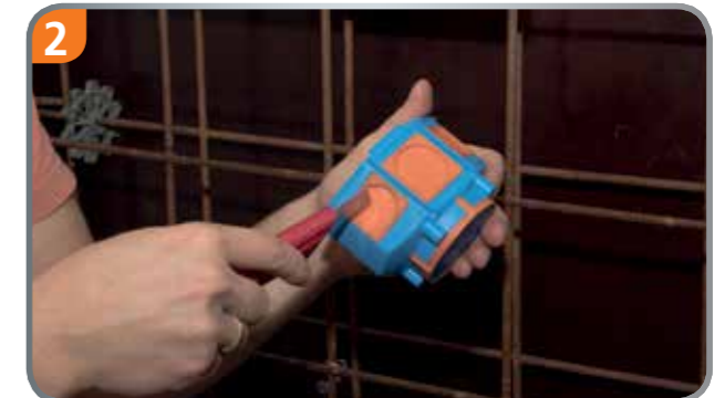
Membraneinführung mit Cuttermesser einschneiden.
