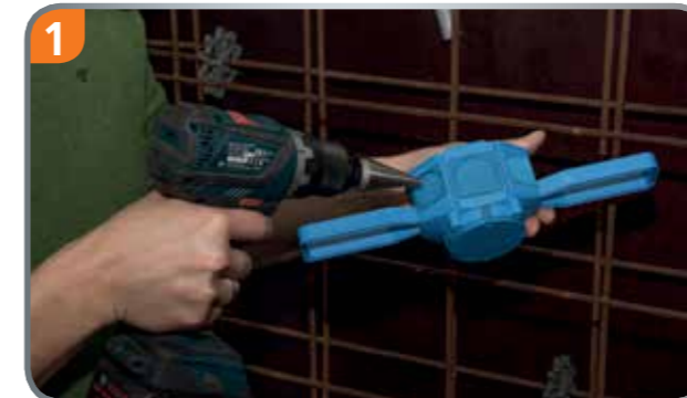
1 Rohrlöcher ausbohren...
