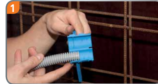
1 Rohr M20 oder M25 einklicken. Absolut sichere Zugentlastung.
