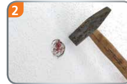
2 Mit dem Hammer leicht auf den Putzdeckel schlagen.
