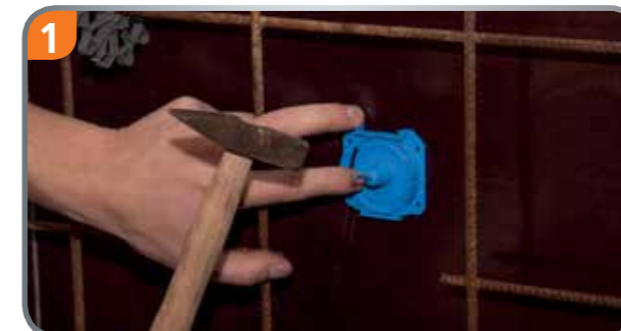
1 Frontteil auf die Schalung nageln.
