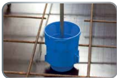
Gerätedeckel mit Nagler auf der Schalung befestigen
