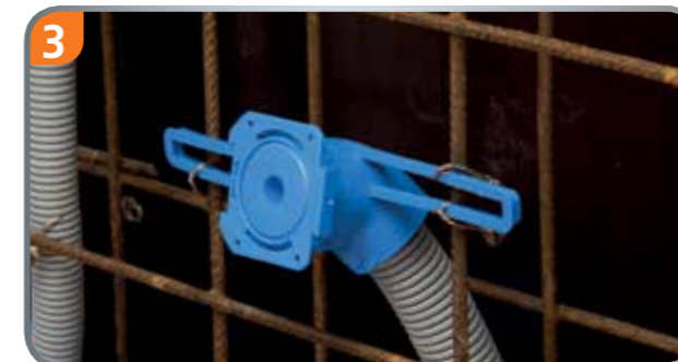
3 Zeitsparende Montage mit Flügel auf der Stahlarmierung.
