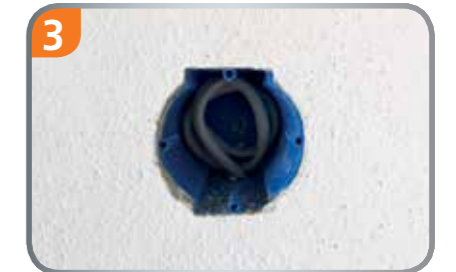
3 25 Sekunden für 5 Dosen ausbohren und Deckel entfernen (siehe Video).
