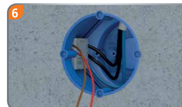
6 Elektronikdose: Genügend Platz im Inneren für Elektronikbauteile.
