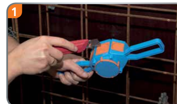
1 Membraneinführung mit Cuttermesser einschneiden.
