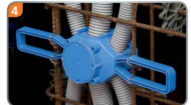
4 Flügel werden mit Draht an der Bewehrung verdrillt.
