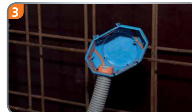
Perfekter Halt durch integrierte Zugentlastung (Rohrgrip).
