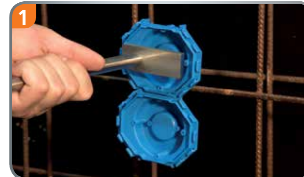
Deckel mit dem Primo-Nagler auf Schalung nageln.
