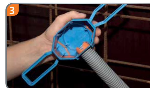
3 Perfekter Halt durch integrierte Zugentlastung (Rohrgrip).
