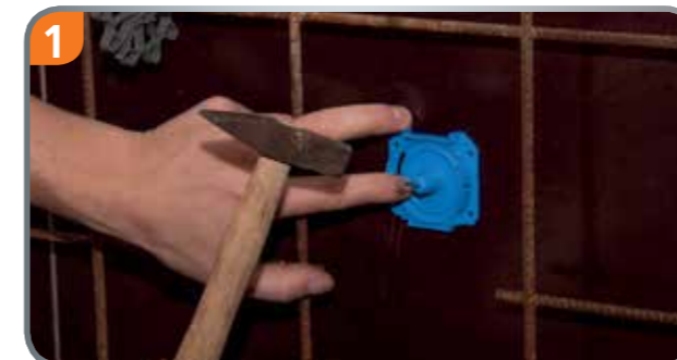
1 Frontteil auf die Schalung nageln.
