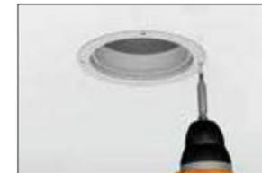
Tellerventil einfach anschrauben ohne Bohren.
