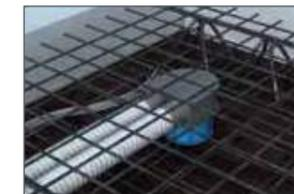
Obere Bewehrung einbringen und betonieren.
