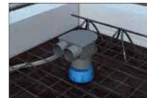
Stützen in die Lüftungshülse einstecken.
