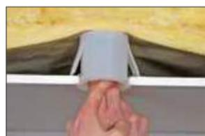
Schutzkappe in Bohrloch einschieben.
