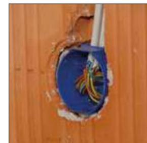
Unterteil bündig setzen. Elektrokabel oder Rohre einbringen.
