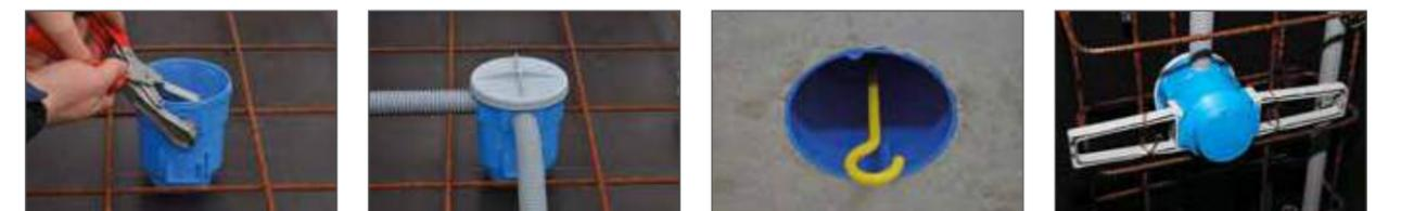
Universaldose mit Nägeln auf die Schalung fixieren. Loch mit Stanzzange ausstanzen. Montage als Deckengrößdose. Montage mit Deckenhaken. (Maximale Belastung 10 kg). Montage als Elektronikgrößdose mit Flügeln.
