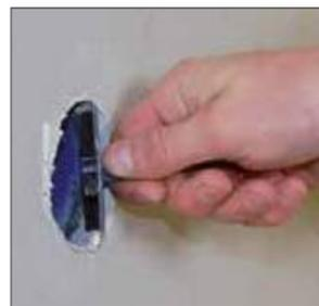
Leichtes Rausnehmen des durchfrästen Bohrdeckels.
