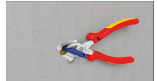
Leitungsträger mit Zange bündig zur Wand abzwicken.
