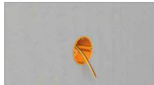
Hohlwanddose montieren und Einbaugerät/Steckdose installieren.
