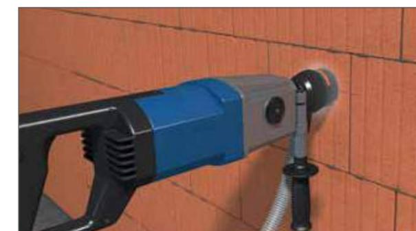
Erste Dose anzeichnen und mit Ø 82 mm Schnellläufer ausbohren.
