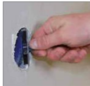
Leichtes Rausnehmen des durchfrästen Bohrdeckels.
