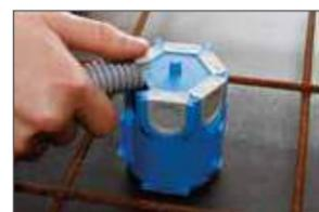
Rohr mit Quick-Fix-Schieber einschieben und schließen.
