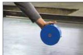
2. Variante: Mit Magnet auf Schalung positionieren.
