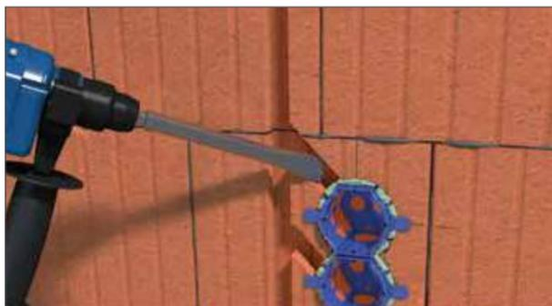
Bei ausgehärtetem Schaum den verbleibenden Steg ausbrechen.
