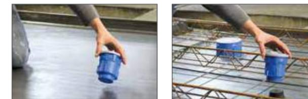
1. Variante: Mit Heißkleber auf Schaltisch kleben. 2. Variante: Mit Magnet auf Schaltisch positionieren.
