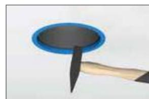
Lüftungshülse von unten mit Hammer einschlagen.
