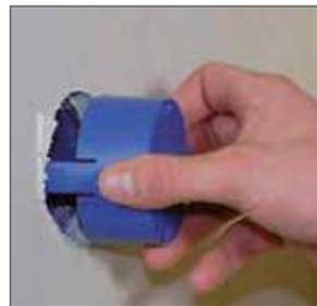
Aufstecken des Dosenoberteils und Einschieben bis zur Bündigkeit.
