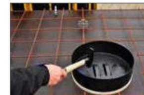
Im Ortbeton auf Schalung nageln oder im Fertigteilwerk auf den Schal-tisch kleben.
