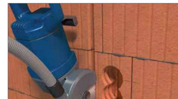
Schlitz mit Mauernutfräse entlang der Bohrungen fräsen.
