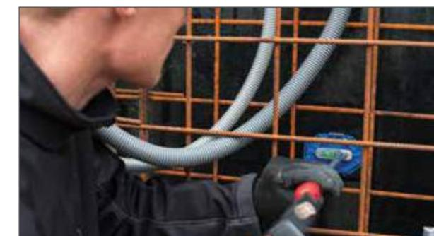
Mithilfe integrierter Wasserwaage ausrichten und aufnageln.
