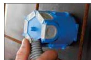
Rohr mit Quick-Fix-Schieber einschieben und schließen.
