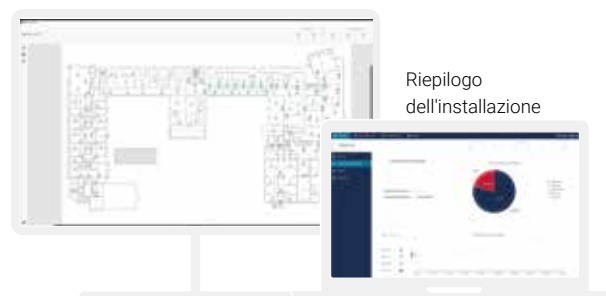
Programma di controllo Normalink BMS.
